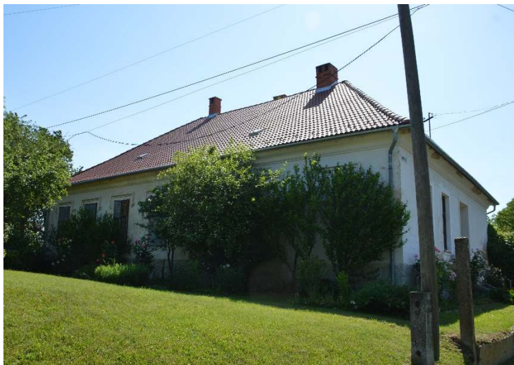
38. ábra Az épület tér felőli homlokzata
