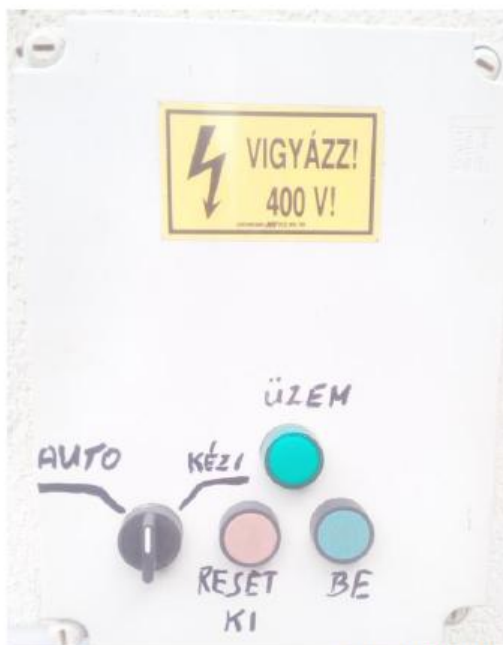
3. ábra Biofilter villamos kapcsolószekrény
