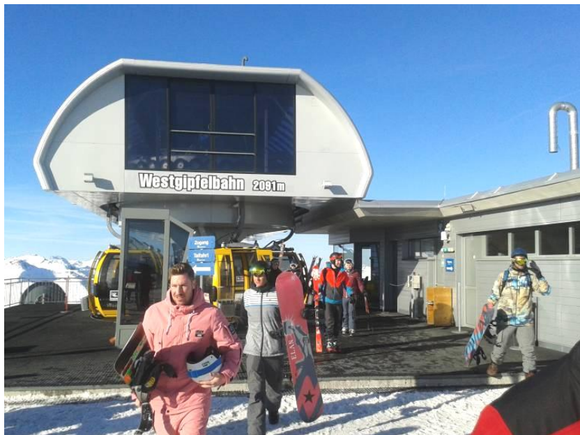
M 4/14: A szöveges részben is bemutatott hegyállomás , 8 személyes kabinnal, a kötél feszítés ebben van. Lehet ilyen szabadon álló. (Fotó: SchT)
