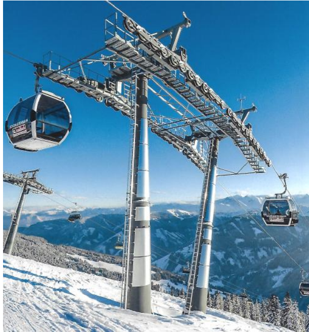
M 5/2: Doppelmayr cég kónikus oszlopa 8 személyes kabinokkal a képen
