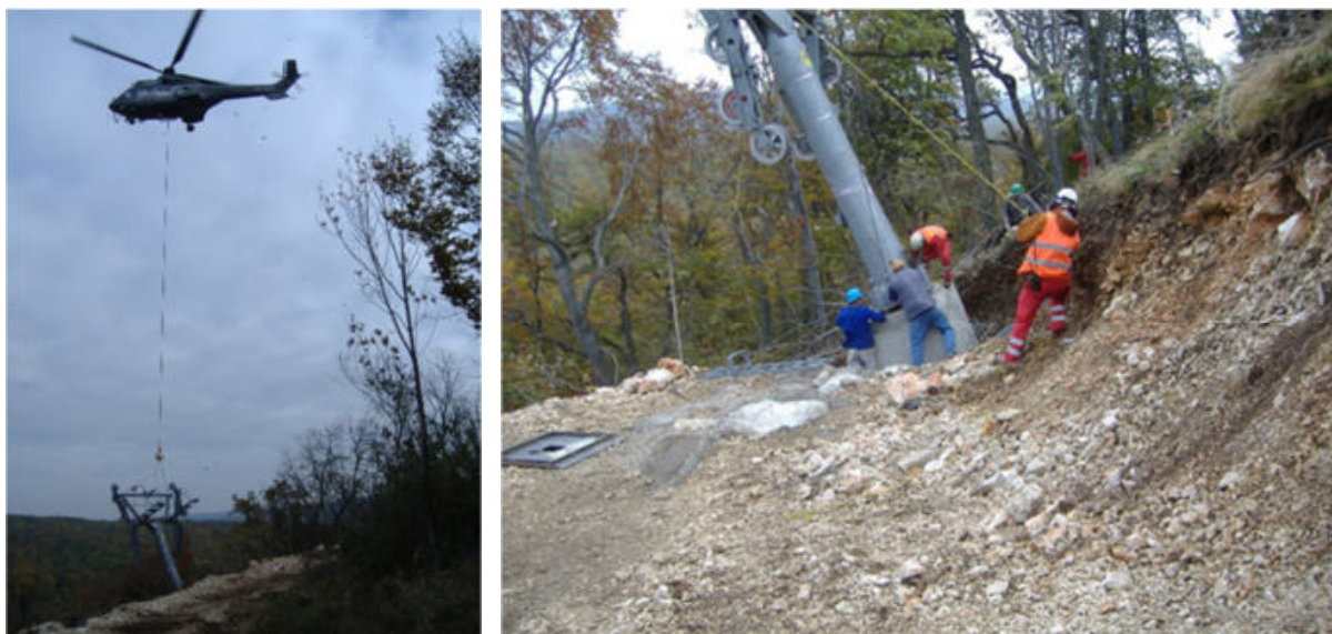
34. ábra: A tartóoszlopok beemelése helikopterrel
