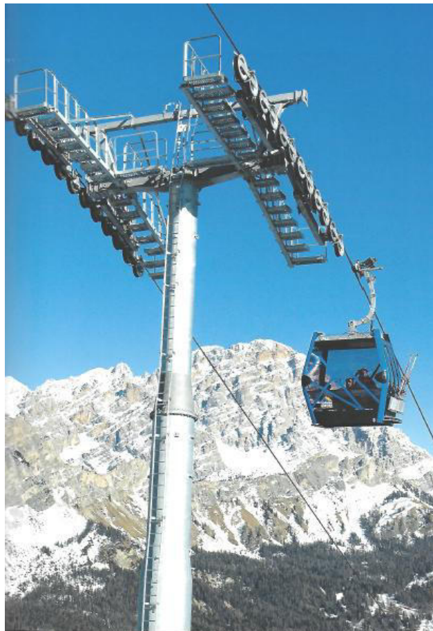
M 5/3 Leitner cég két-három csőátmérővel készülő oszlopa 10 személyes kabinnal (Forrás: nyilvános gyártói prospektusok)
