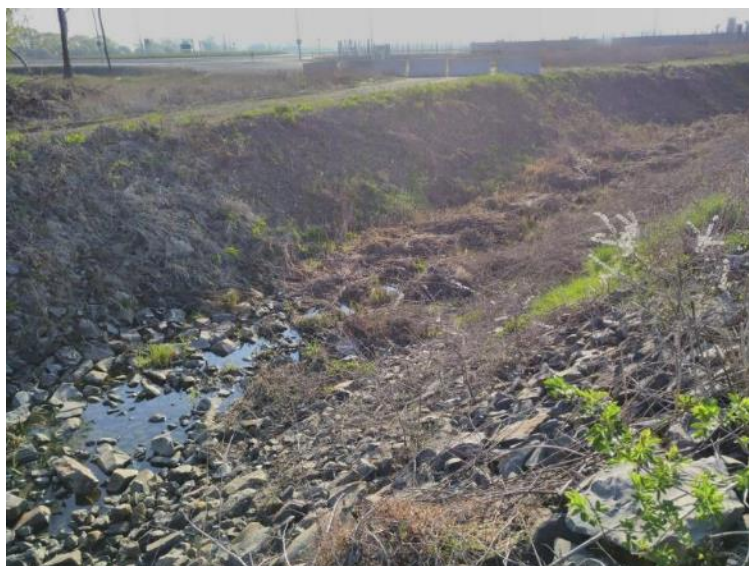
64. ábra Kőszórással érintett mederszakasz a 6+880 fkm szelvélynél található híd mellett
