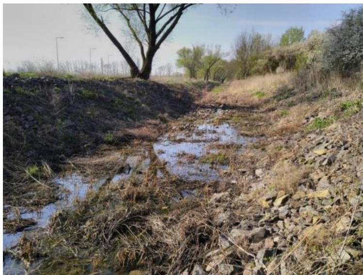
63. ábra Kőszórással módosított meder és rézsűk, a jobb parton (kép jobb oldala) a depónián kökény cserjéssel, a bal parti depónián (kép bal oldala és közepe) jellegtelen gyomnövényzettel és néhány hagyásfával (6+630 fkm szelvénynél)
