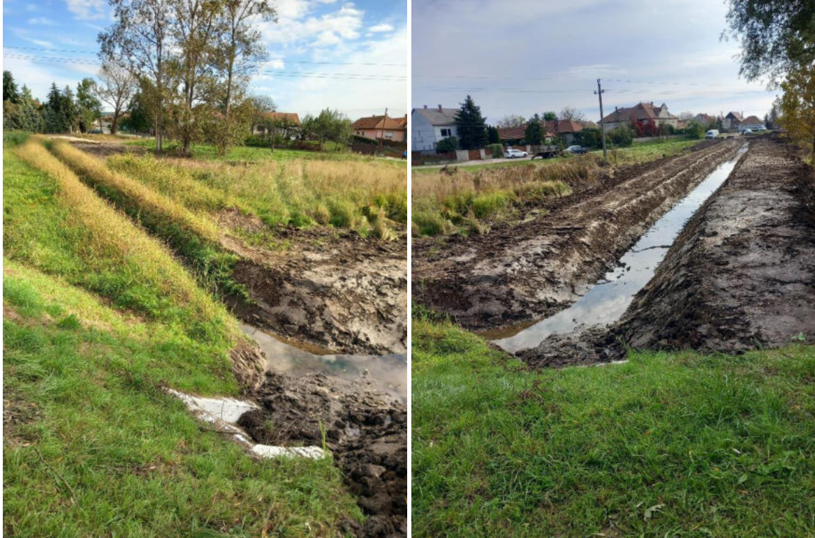
6-7. kép: Kétágú csapadékvíz elvezető csatorna épülőben, háttérben az ideiglenes elöntési terület, valamint a lakóövezet
