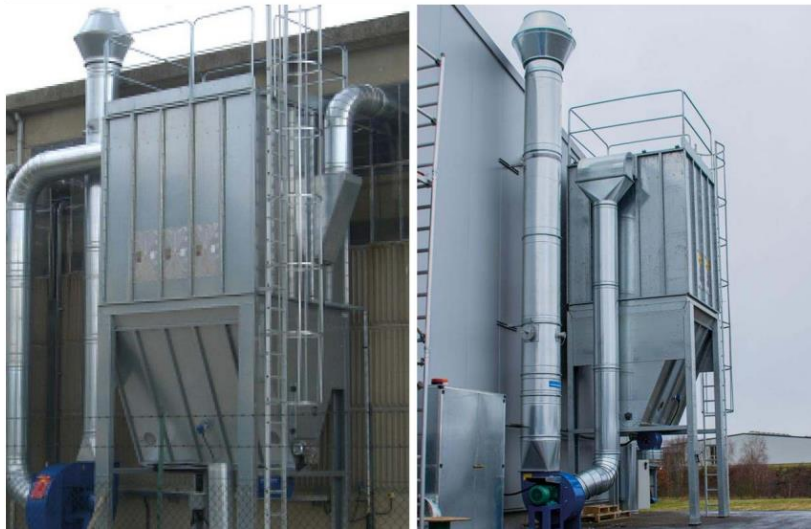
32. számú fotó: PANIZZOLO Refining légtechnikai elszívó egysége
