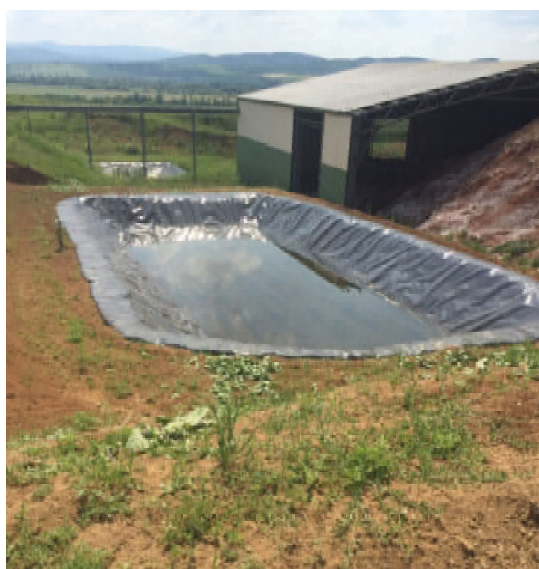
6. kép A III. ütemhez kialakított szennyvíz-gyűjtő medence
