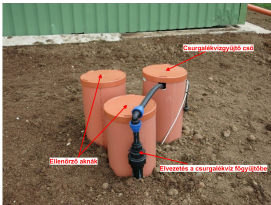
4. kép Az V. depónia ellenőrző csövei
