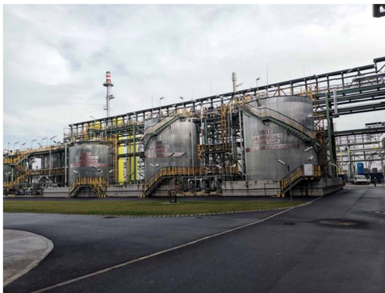
5. kép Üzemi termék tároló tartályok. Balról jobbra haladva az S-4211 MNB tartály, az S-5710/A és S-5710/B anilin tárolók
