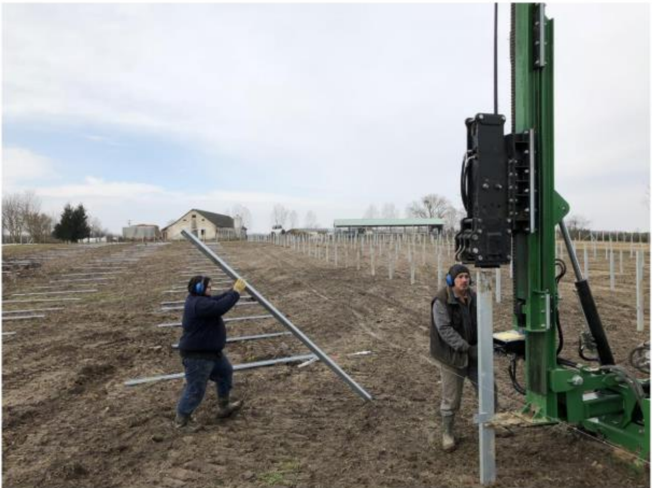
1. fotó: A tartószerkezet lesajtolása
