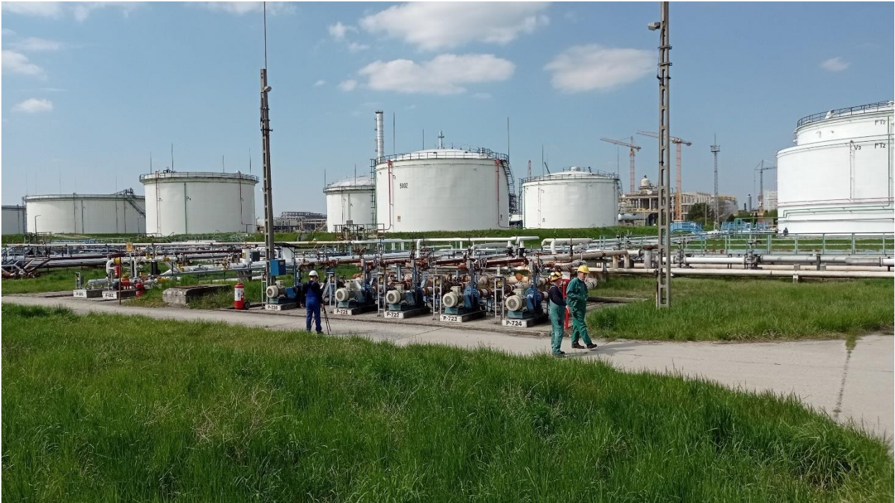
19. ábra: M11 Tankautó töltő szivattyútér
