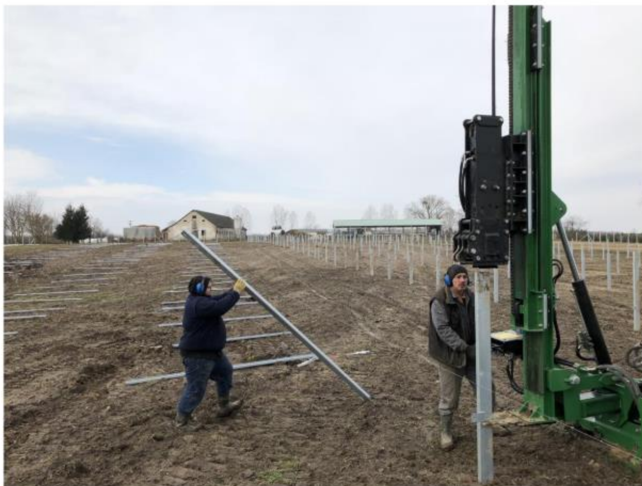
1. fotó: A tartószerkezet lesajtolása
