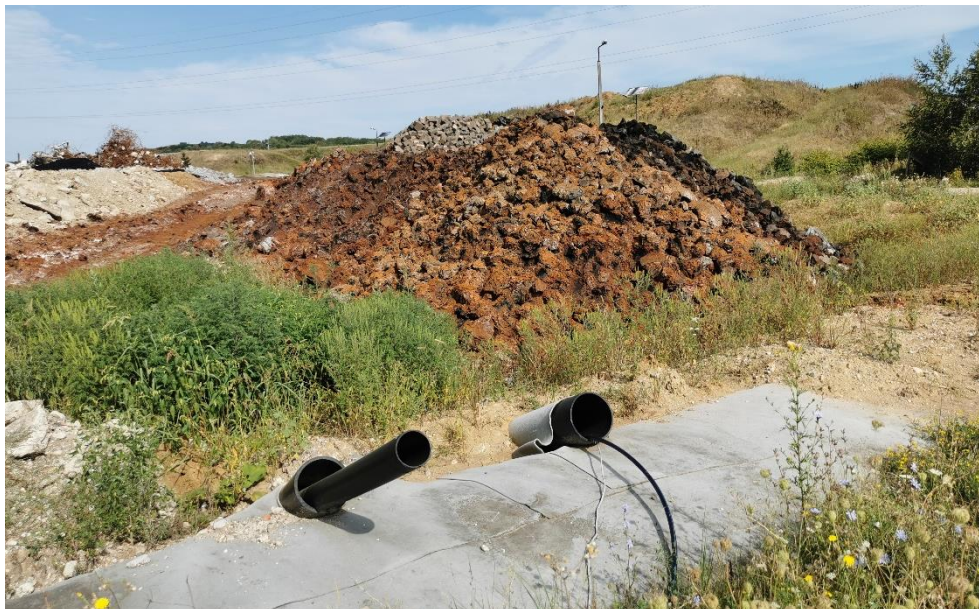
11. ábra: A III. ütem szekunder és terciér szivárgóinak kivezetései (2024. augusztus)
