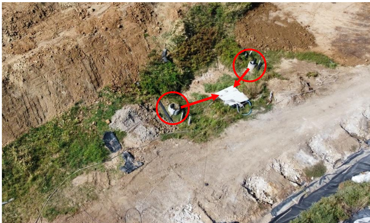
12. ábra: Csurgalékvíz gyűjtő aknák a II. ütem lábánál.
