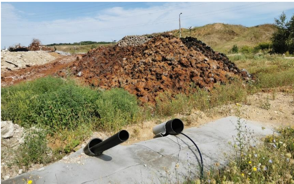
13. ábra: A III. ütem szekunder és terciér szivárgóinak kivezetései (2024. augusztus)
