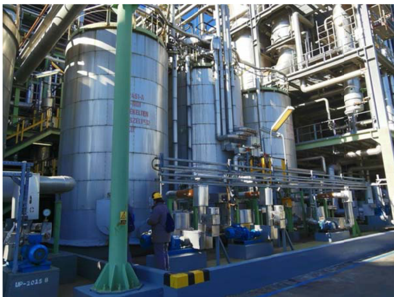
11. kép Az MDI Üzem munkatársa szemlézi a cserélendő US-2451 üzemi közti Cr-MDI tartály
