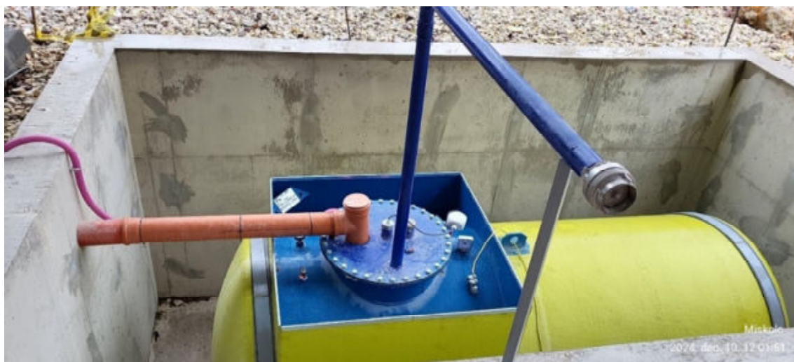
4. kép: Csapadékvíz-gyűjtő tárolótartály (2024. december)
