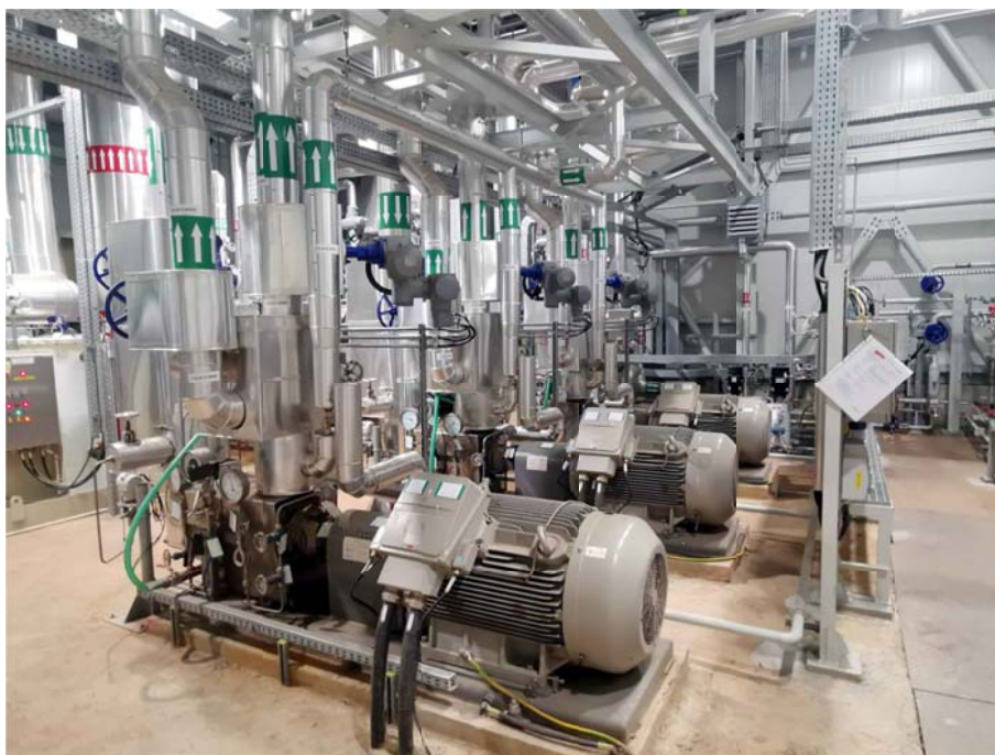
13. kép A kazántápvíz szivattyúk
