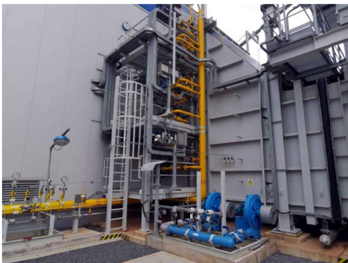
12. kép A hőhasznosító kazán (HRSG) pótégőit földgáz tüzelőanyaggal ellátó rendszer
