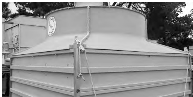
14. Ábra : Szervizpanel-rögzítési pontok.
