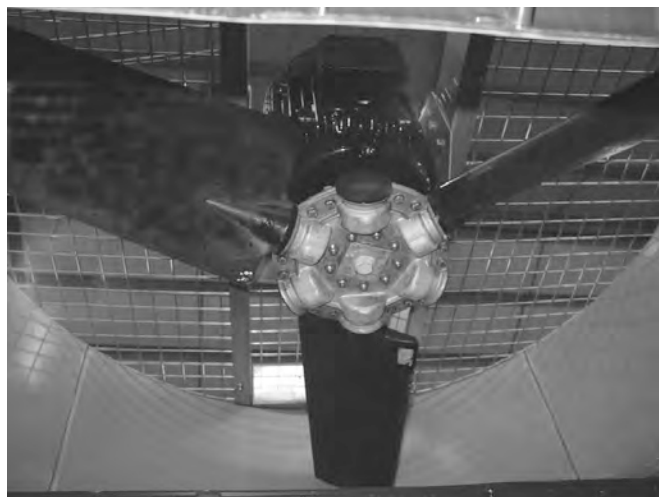
13. Ábra : Közvetlen hajtású axiálventilátor
