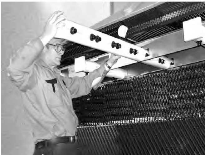
11. Ábra : Eltávolítható porlasztórendszer
