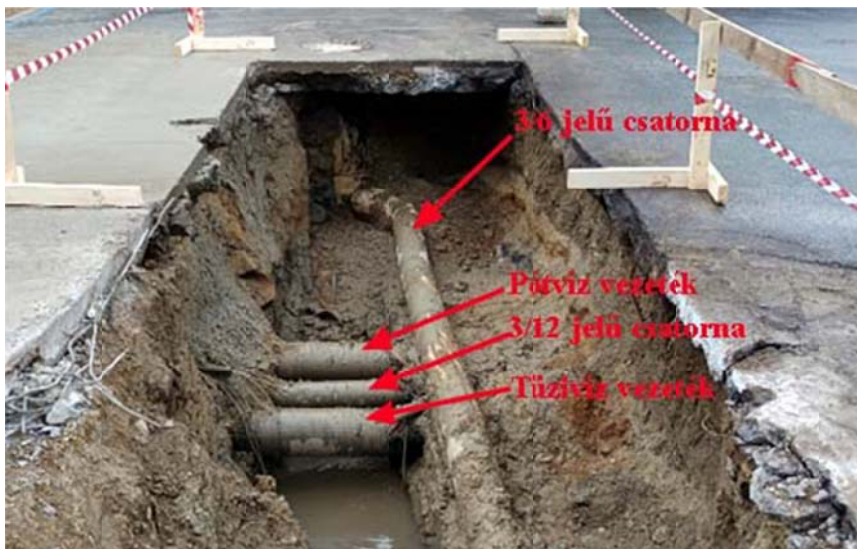
7. kép Feltárás a 3/6 szerves és 3/12 szervesetlen földalatti csatornák keresztezési pontjainál
