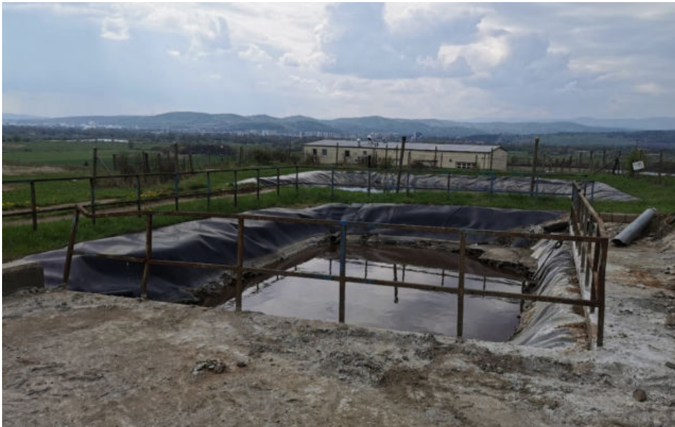
21. ábra: A 80 m 3 -es csurgalékvíz-gyűjtő medence állapota, háttérben a 300 m 3 -es csurgalékvíz-gyűjtő medence (2023. április)
