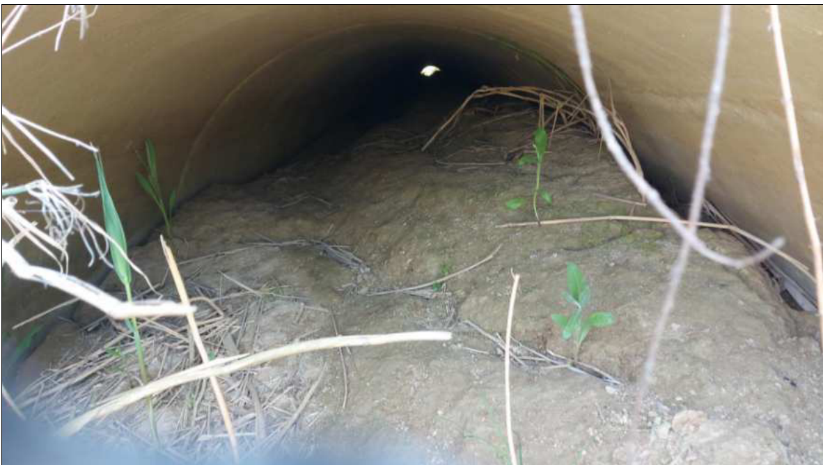
16. számú kép: A villámárvizek levezetése nem csak a belépési pontnál lévő áteresznél, hanem a kilépési pontnál lévő áteresznél is kérdéses. Ebben az esetben a már elkészült M3 autópályától északra és délre lévő területek közötti fajközvetítő funkció is megkérdőjelezhető.
