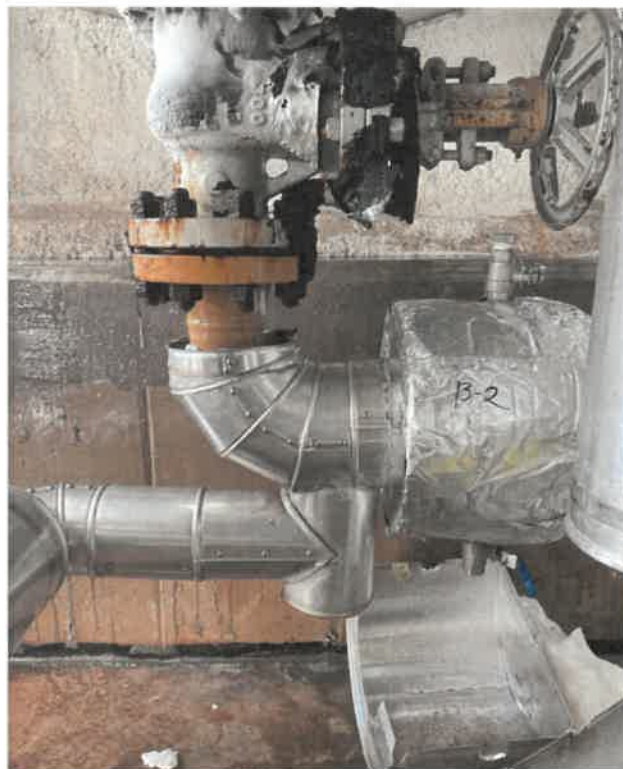
1. számú ábra: LT szinttávadó és az alapszerelvény az eseményt követően
