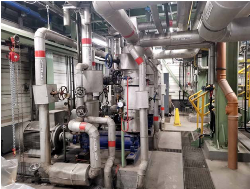
7. kép A segédkazánok tápvíz rendszere
