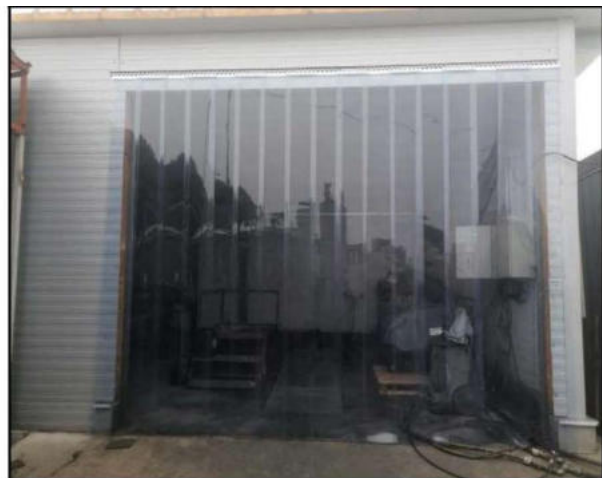
IBC mosó átalakítás után, szalagfüggönnyel
