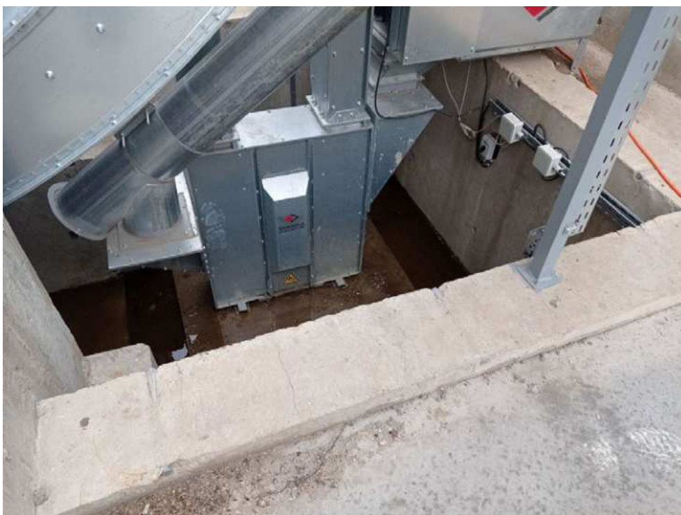
3. fotó: A terményszárító szerelvényaknájának falát meg kell magasítani
