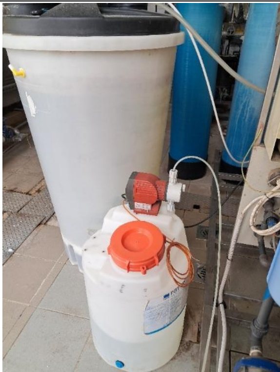
23. kép: Kazánvíz előkészítő (lágyítás)
