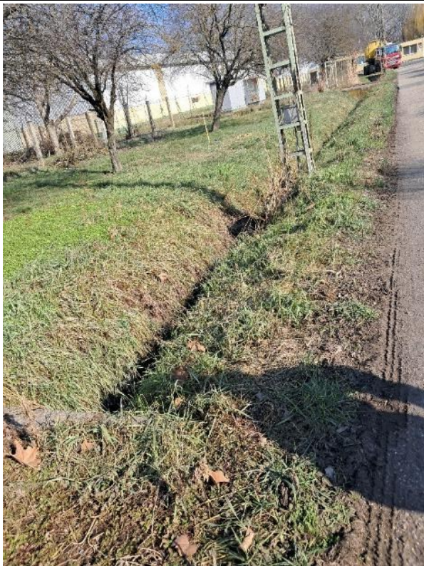
9. kép: Csapadékvíz elvezető/szikkasztó árok 2
