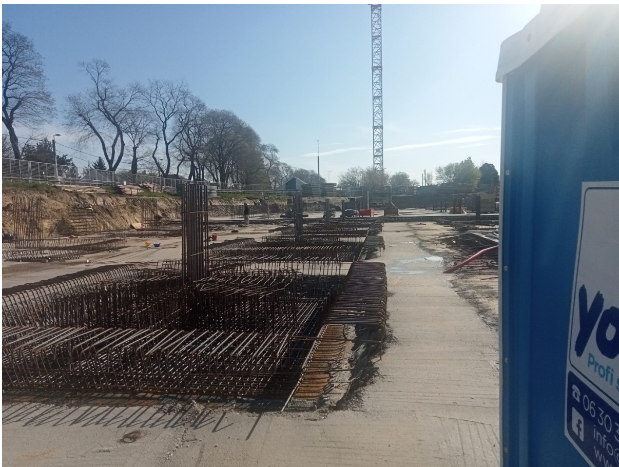
A „C” épület kész pinceszinti alaplemeze és a felmenő szerkezetek vasalásai
