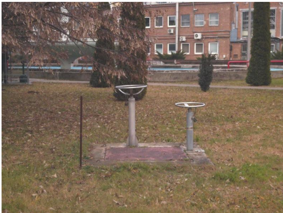
15. sz. kép: csatorna lezárási pontok
