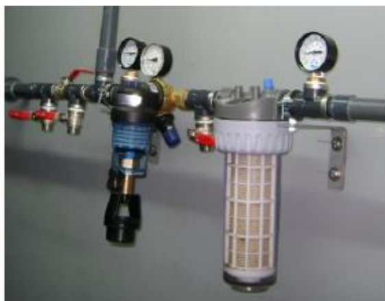
8. ábra Tervezett vizes főcsatlakozó kialakítása
