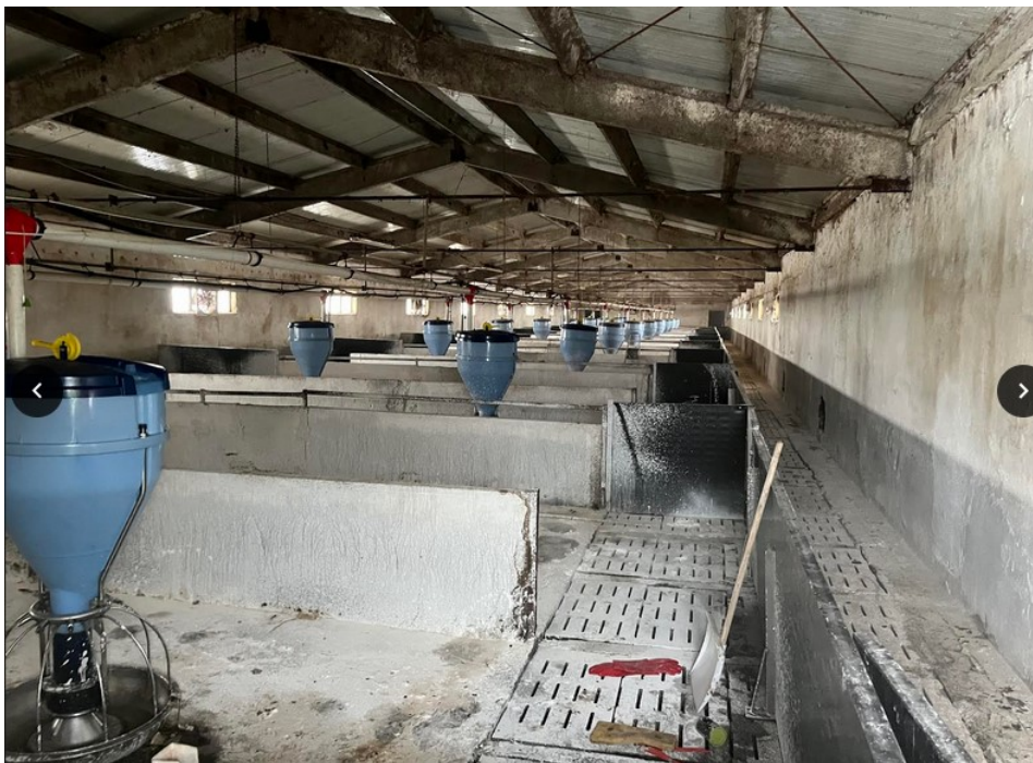
állattartó épület részleges rácspadozattal, etető és itató rendszerrel
