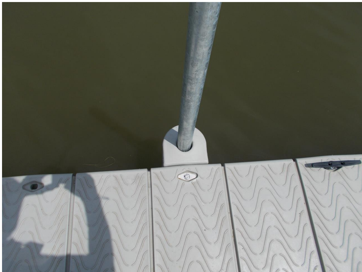
Úszómű rögzítése a fenékhez acélcső cölöppel
