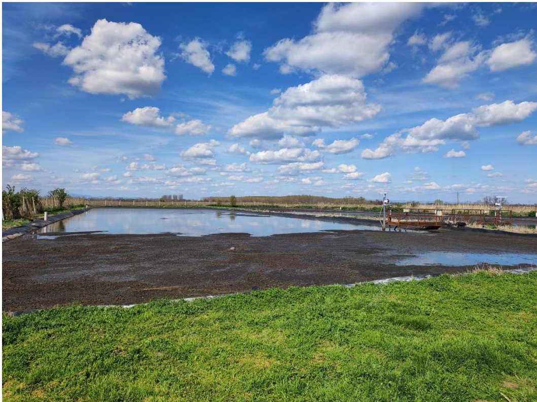
1. kép: A szigetelt hígtrágyatározók az ingatlan DK-i végében
