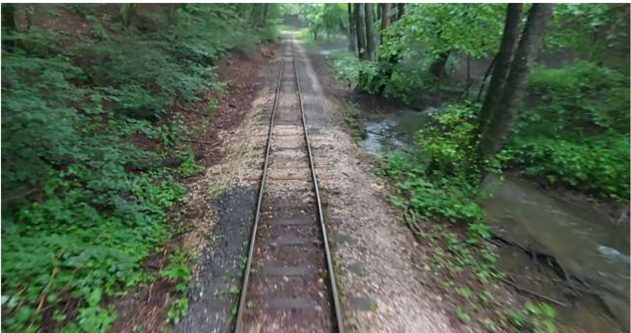
5. számú kép: Egy általános pálya keresztmetszet. A régebbi talpfa cserét jelzi a világos talpfa, valamint a világos mészkő zúzalék. A magasabb részről a pálya árkába, mint helyi erózió bázisra csúszik le az areális erózió szállította talaj. Mind a pálya kőzúzalékában, mind annak árkában védett növények telepedtek meg. A mellette erező patak egyre inkább erodálja a pálya alapját.
