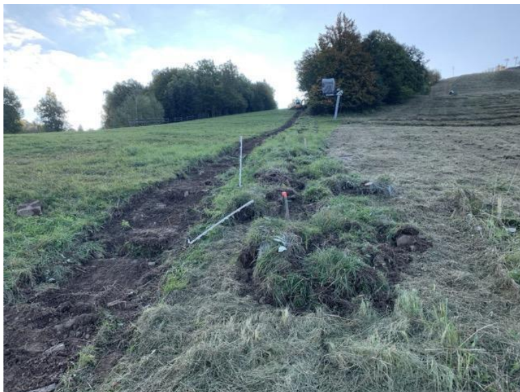
14. fénykép: Hóagyú vezeték csere gyepféglás módszerrel (2020 ősz)
