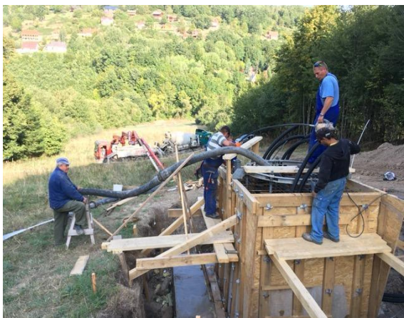
20. fénykép: A Panorámalift tartóoszlopainak építési munkái
