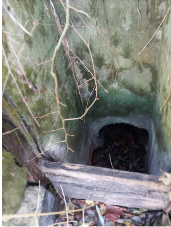
7. kép: Földgát áteresze, hordalékfogó fa zsilippel
