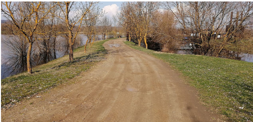
9. fotó: "A" jelű földút a Robinson szigetek tavai között az 1+200 km szelvényénél (2024. március).
