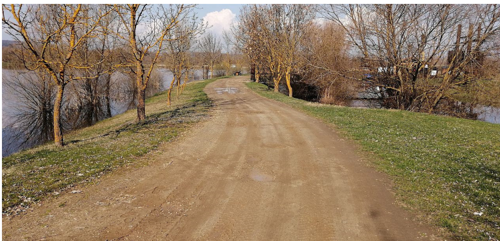
9. fotó: "A" jelű földút a Robinson szigetek tavai között az 1+200 km szelvénynél (2024. március).
