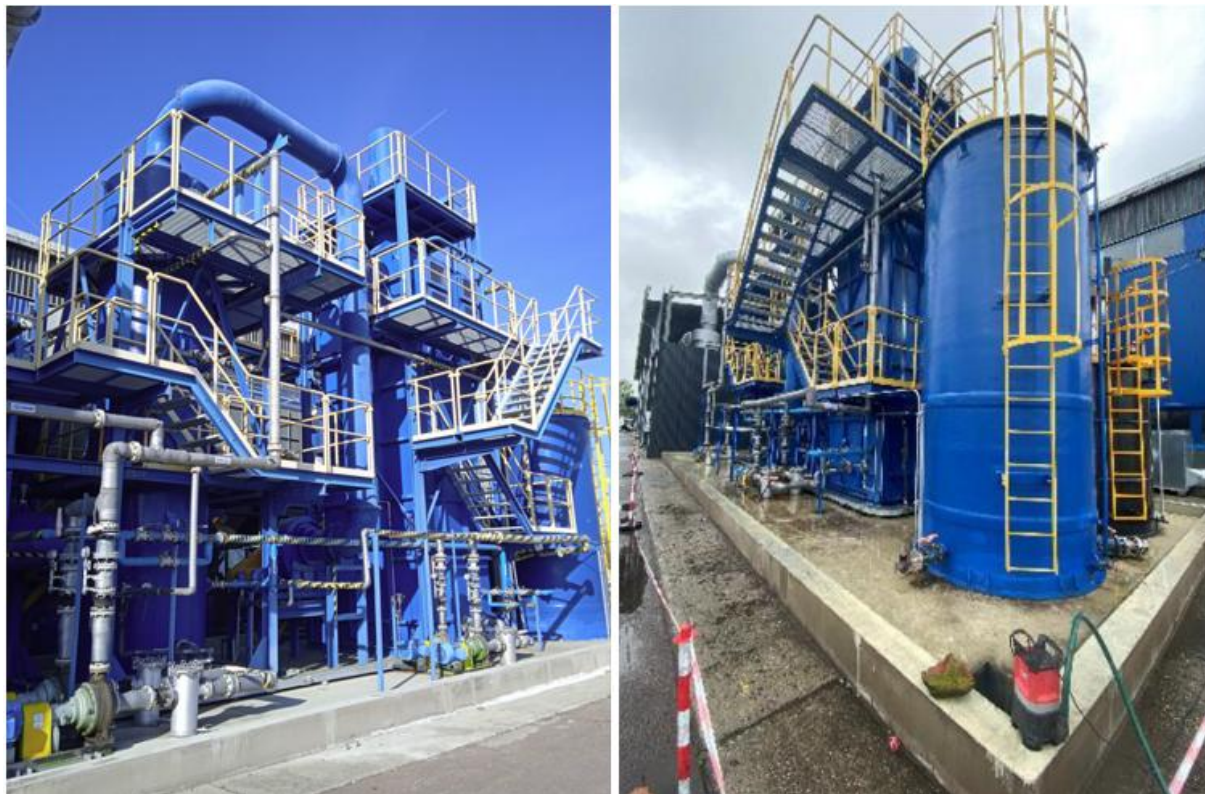
26. ábra: A RTD-berendezés levegőkezelő egységei
