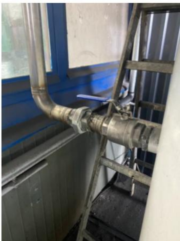
21. ábra: Nitrogéngenerátor és az ipari nitrogén csatlakoztatása
