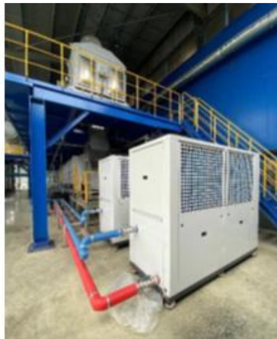
23. ábra: A forgó dobszáritó hűtőegysége és a hozzá tartozó hőszivattyúk
