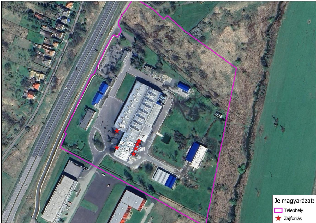
65. ábra: A telephely jelenlegi zajforrásai
