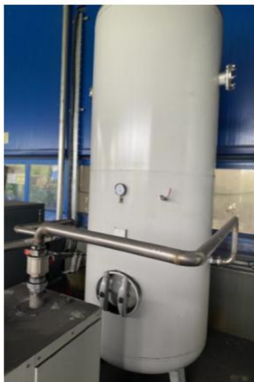
21. ábra: Nitrogéngenerátor és az ipari nitrogén csatlakoztatása
