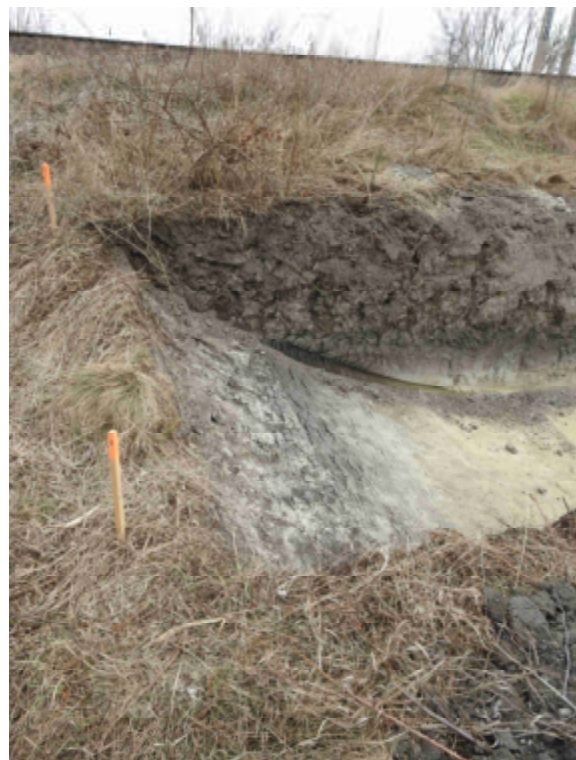
3. – 4. sz. kép: A régészeti szondahelyeken az árok két vége a természetvédelmi előírásnak megfelelően, rézsűsen van kialakítva, így az esetlegesen árokba esett állatok azt akadály nélkül képesek elhagyni.
