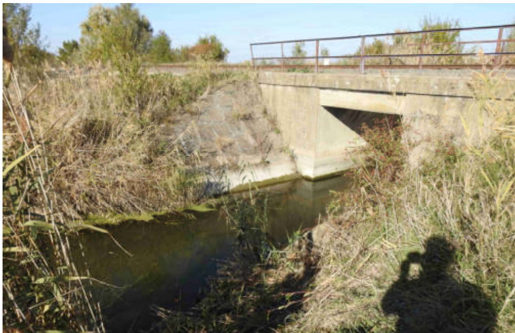
7. sz. kép: Vidrák és egyéb emlősök számára kevésbé alkalmas műszaki kialakítású híd egy állandó vízzel ellátott csatornán. Meredek a rézsű, továbbá hiányzik a száraz átkelést biztosító padka.
