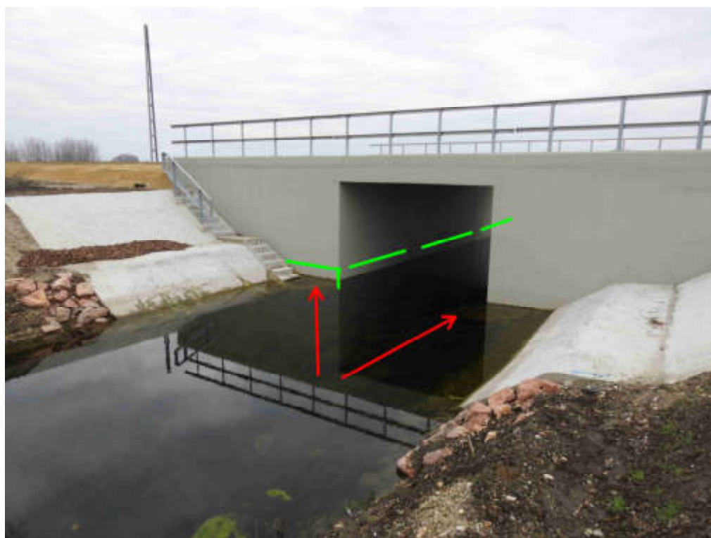
7. sz. kép: Vidrák és egyéb emlősök számára kedvezőbb műszaki kialakítású híd egy állandó vízzel ellátott csatornán.
