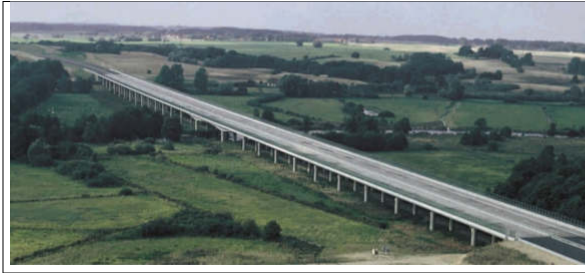
Töltés építés helyett pillérekre építették a németországi A20 autópálya egy szakaszát. Ez az alacsony viadukt megőrzi az alatta lévő árteret. Forrás: https://handbookwildlifetraffic.info/ch-7-fauna-passages-and-other-solutions/7-3-reducing-the-barrier-effect-underpasses/
