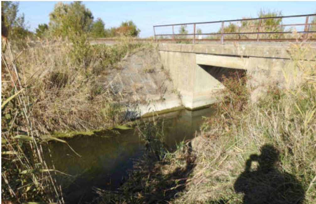
17. sz. kép: Vidrák és egyéb emlősök számára kevésbé alkalmas műszaki kialakítású híd egy állandó vízzel ellátott csatornán. Meredek a részsű, továbbá hiányzik a száraz átkelést biztosító padka.
