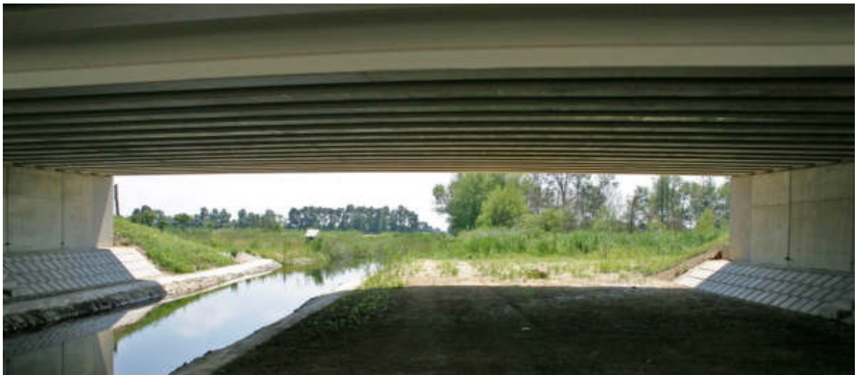
Alsó vadátvezetés a Medvogya-csatorna felett a 155+177 km-sz.-nél az M7-es autópályán, támaszköz: 21,92 m
