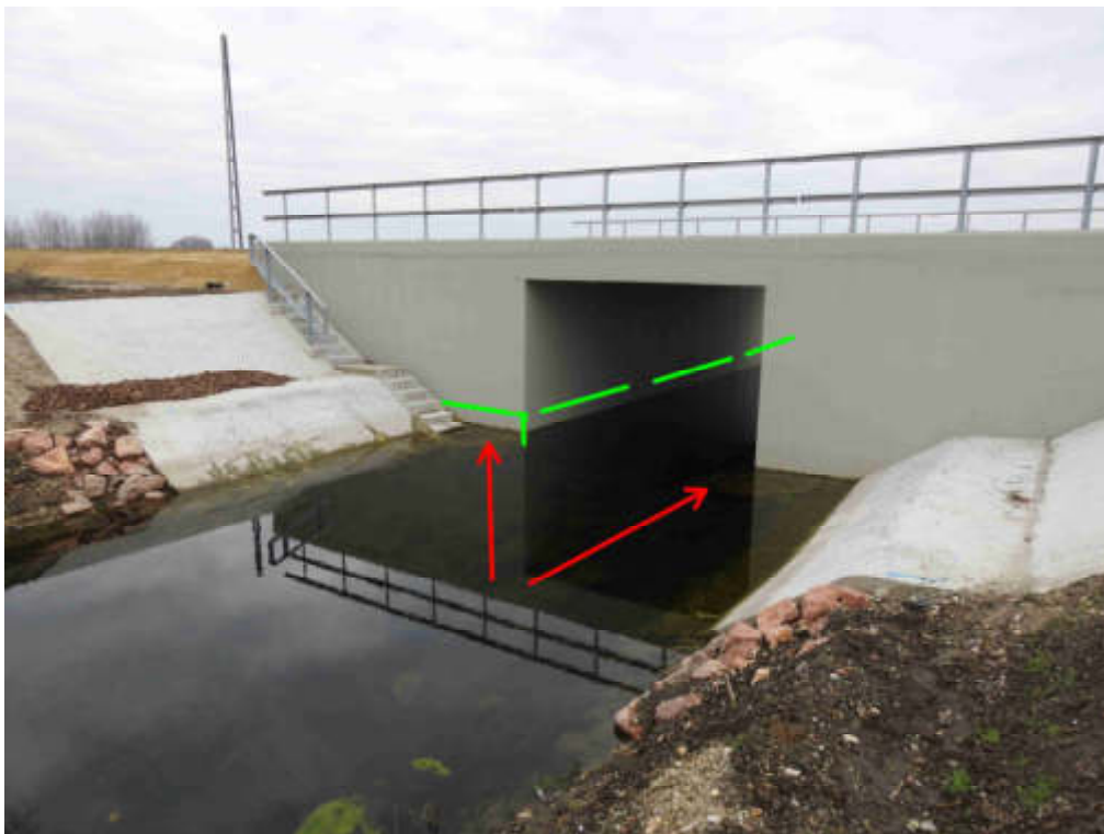
18. sz. kép: Vidrák és egyéb emlősök számára kedvezőbb műszaki kialakítású híd egy állandó vízzel ellátott csatornán.
