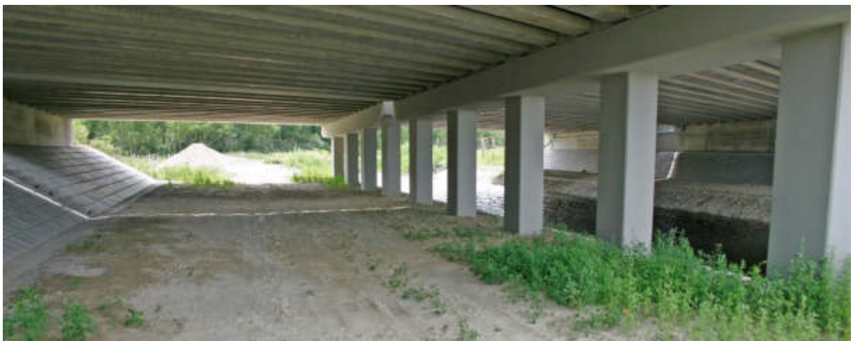
Alsó vadátvezetés a Medvogya-csatorna felett a 155+177 km-sz.-nél az M7-es autópályán, támaszköz: 21,92 m
