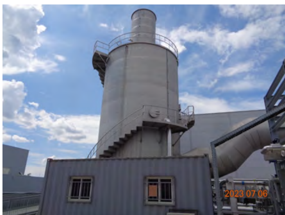
I. főépület 92 m tetején lévő gázmosó oldószer visszanyerő (P95)
