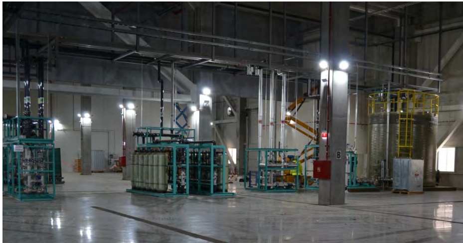
DI tartály, DI recirkuláció, UV és MMF szűrők a II. közmű épület DI rendszeren
