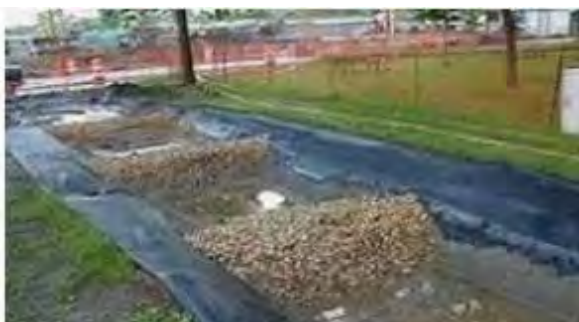
3.3.2.3.b kép: Ideiglenes csapadékvíz gyűjtő medence
