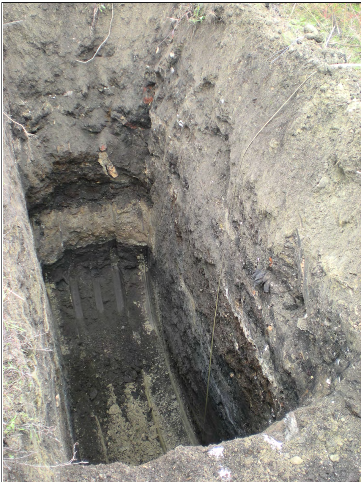
6. fotó: az R4 feltáró fúrás helyén 3,8 m-es mélységgel létesült a kutatóárok
