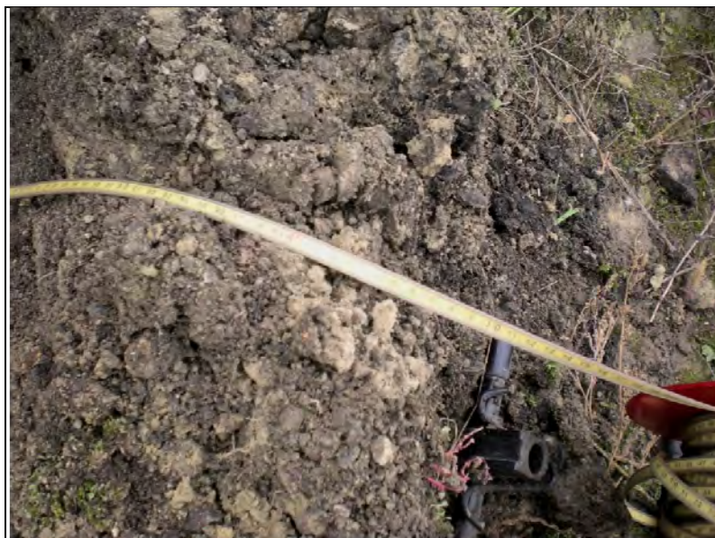
5. fotó: az R4 feltáró fúrás helyén 3,8 m-es mélységgel létesült a kutatóárok
