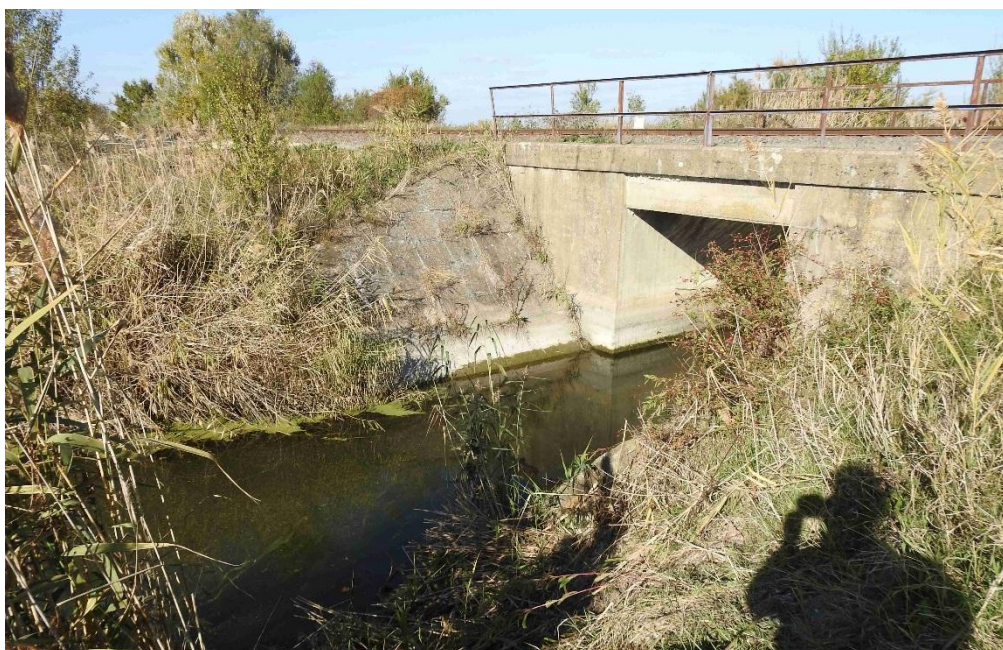
38. ábra Vidrák és egyéb emlősök számára kevésbé alkalmas műszaki kialakítású híd egy állandó vízzel ellátott csatornán. Meredek a rézsű, továbbá hiányzik a száraz átkelést biztosító padka
