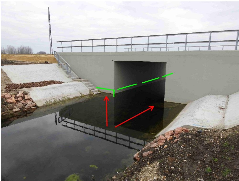
39. ábra Vidrák és egyéb emlősök számára kedvezőbb műszaki kialakítású híd egy állandó vízzel ellátott csatornán
