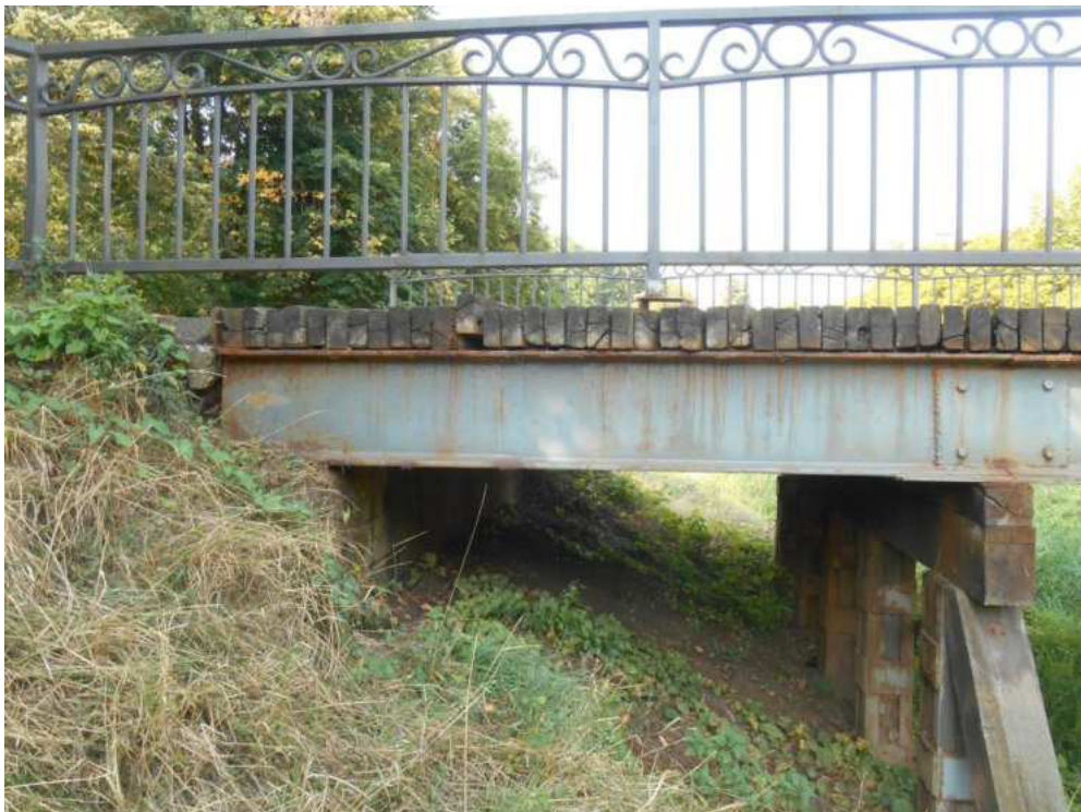
18. Kifolyási oldali felszerkezet.
