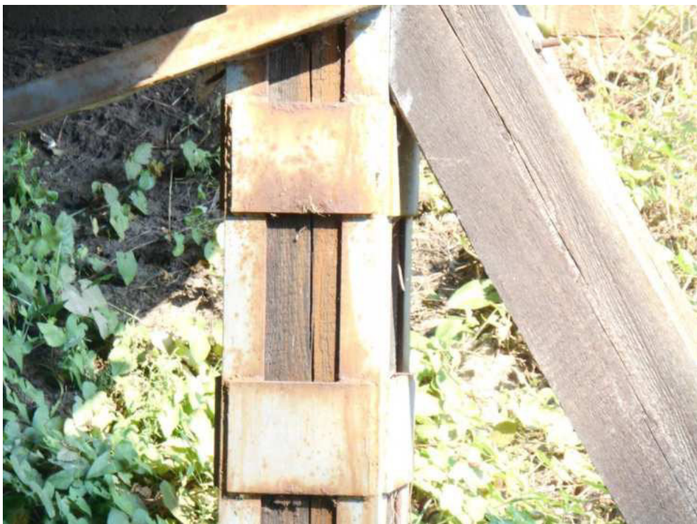
10. Elrepedt fa oszlopok, rozsdás kaloda
