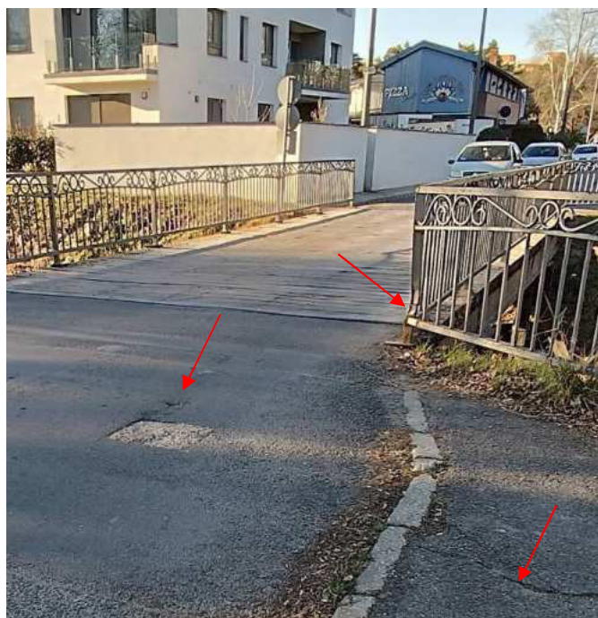
8. és 9. kép: Pályaburkolat, illetve csatlakozás a jobb parti (D-i) hídvég felől.
