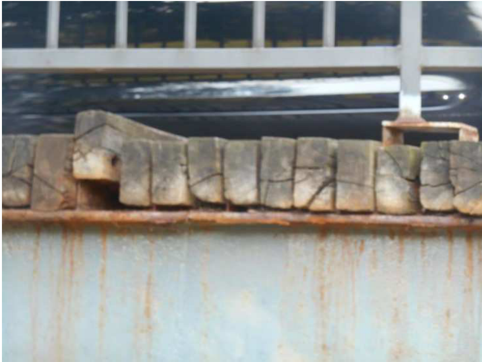
19. Előző kép közelebbről. Egyes járópallók minden egyes áthaladó jármű áthaladásakor megemelkednek. A képen látható kiemelkedő palló felemelkedése 4-5cm.
