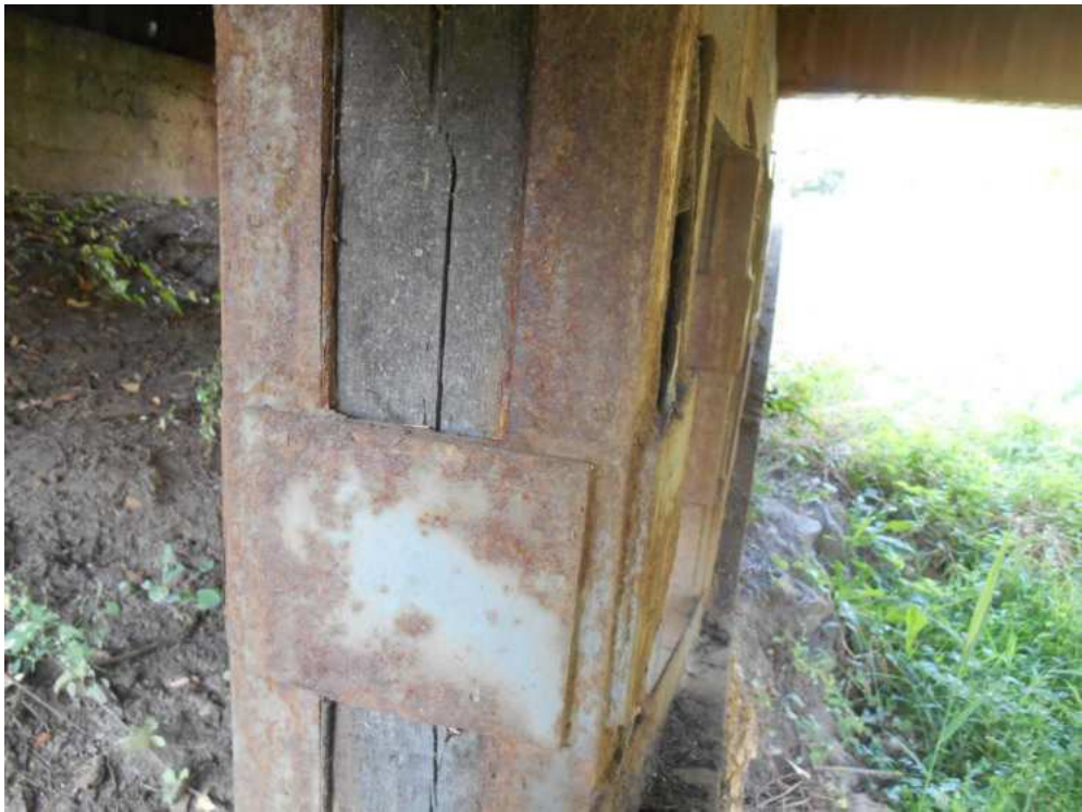
5. Elrepedt fa oszlop, rozsdás kaloda
