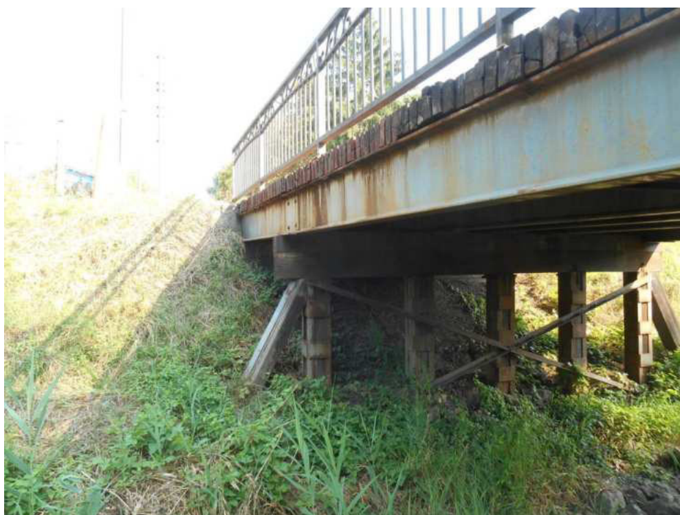
11. A híd befolyási oldala.
