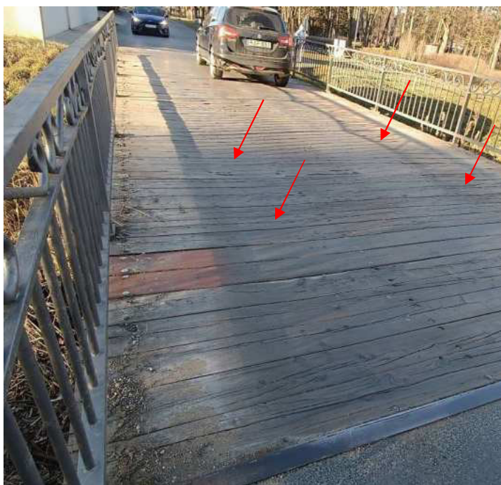
8. és 9. kép: Pályaburkolat, illetve csatlakozás a jobb parti (D-i) hídvég felől.
